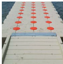
Bevestiging van de loopbrug aan de steiger
