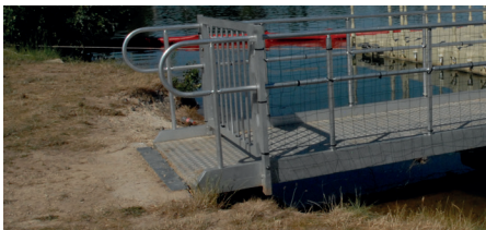
Bevestiging van de loopbrug aan de oever
